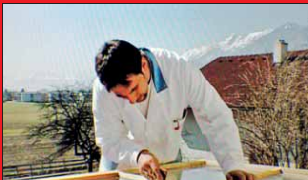
Odstránenie nekompaktných častí starého náteru a dôkladné prebrúsenie.
