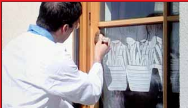
Aplikácia renovačných náterov pri krycom systéme renovácie.
